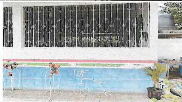
Foto 1: Pintura en muros de interiores y exteriores
