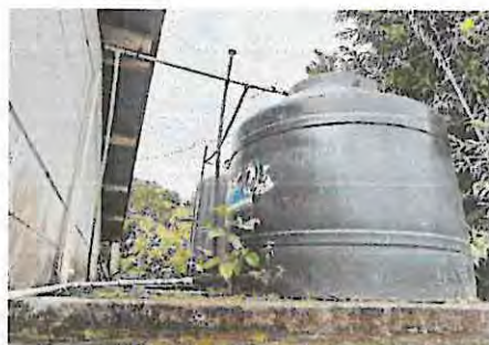
Foto 12: Sustitución de tubería PVC para agua potable
