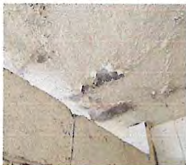
Foto 9: Pintura en el interior de los sanitarios
