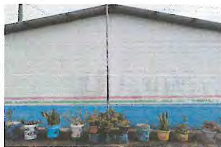
Foto 8: Pintura en exterior
