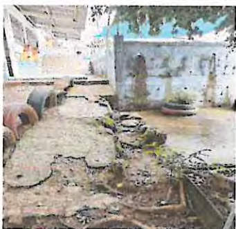
Foto 11: Pintura en muros exteriores
