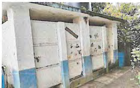
Foto 10: Mantenimiento de puertas de metal (lijado y pintura)
