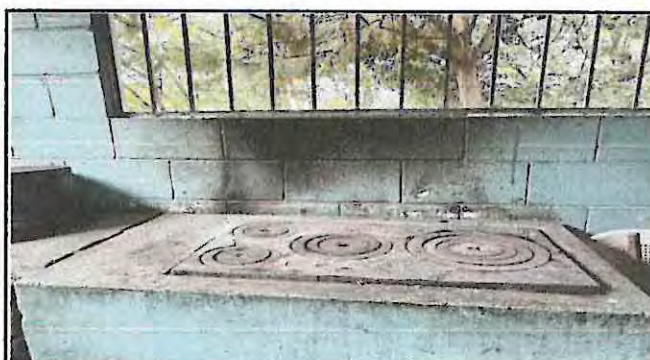
Foto 4: sustitución de plancha de metal
