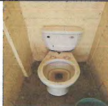
Foto 2: Cambio de sanitarios
