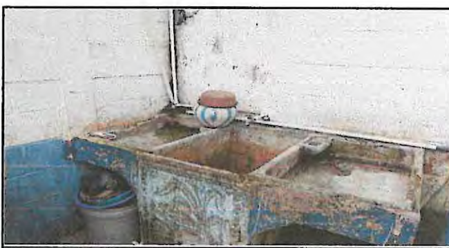
Foto 6: sustitución de pila
